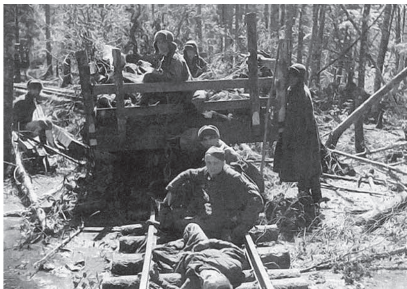
Вывоз раненых бойцов по узкоколейной железной дороге в районе Мясного бора Фото ГК «Автодор»
