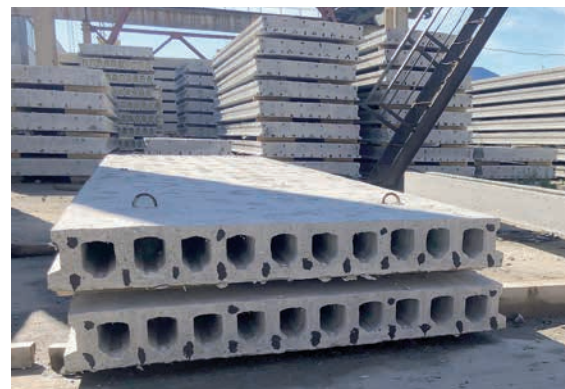
Сборные железобетонные плиты перекрытий высотой сечения 180 мм Фото Максим Шигиев
