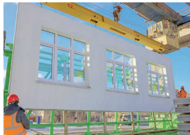
Погрузка на панелевоз девятиметровой наружной стеновой панели Фото Василий Кобин
