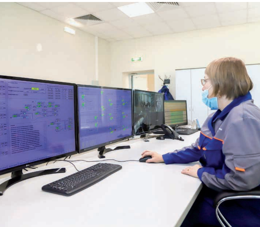
На диспетчерский пульт очистных сооружений канализации автоматически поступает вся информация с контролируемых объектов
