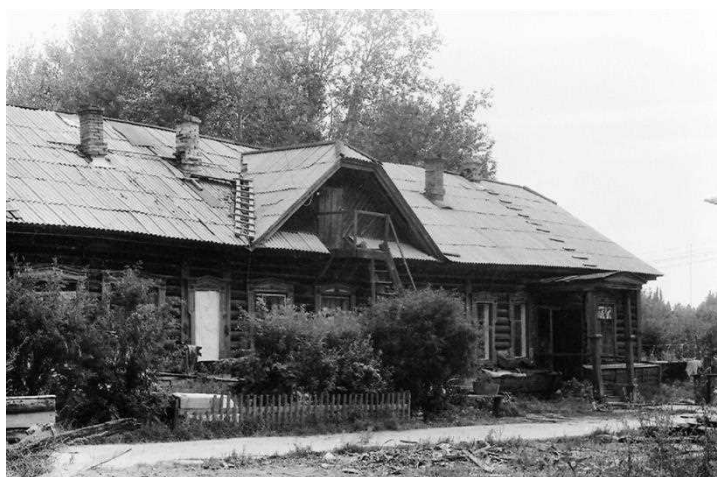
Обветшала контора бывшей сельскохозяйственной опытной станции
