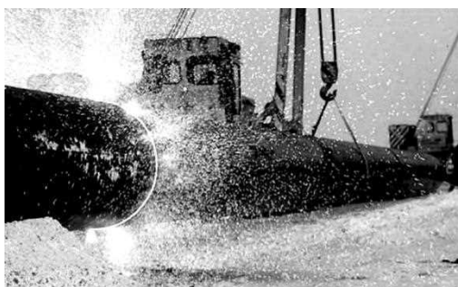
Сварочный комплекс «Север-1» в деле на Уренгойской трассе (слева) и на заводском стенде
