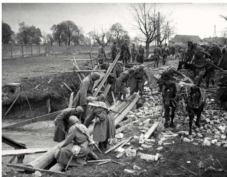
Строители-сапёры за работой
