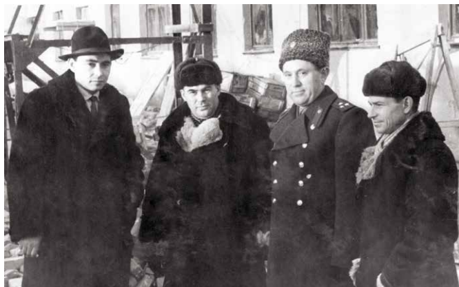
На строительной площадке. 1964 г.
